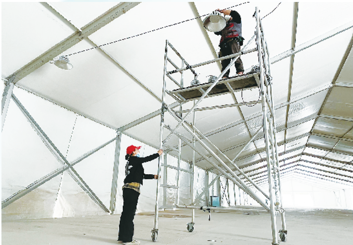
施工人员正在安装篷房内部的照明设备。本报记者 白国华 摄
