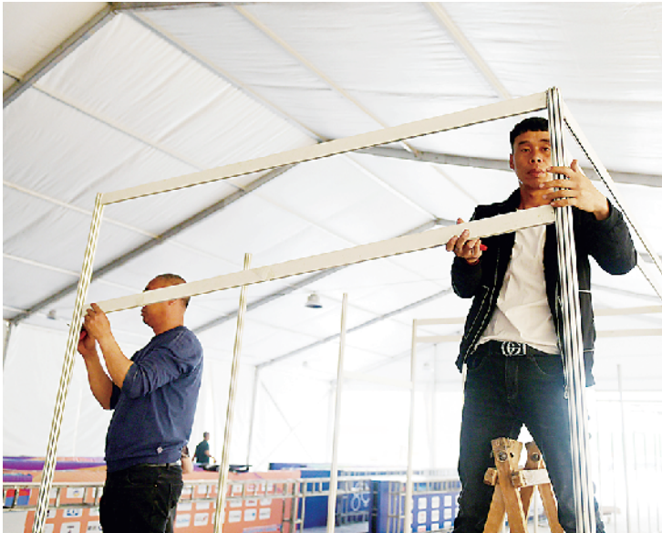
工作人员在有序施工。
