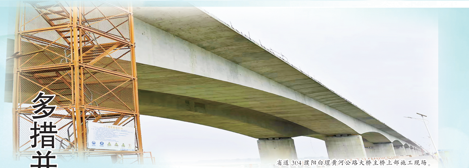
省道 304 濮阳白堍黄河公路大桥主桥上部施工现场。
