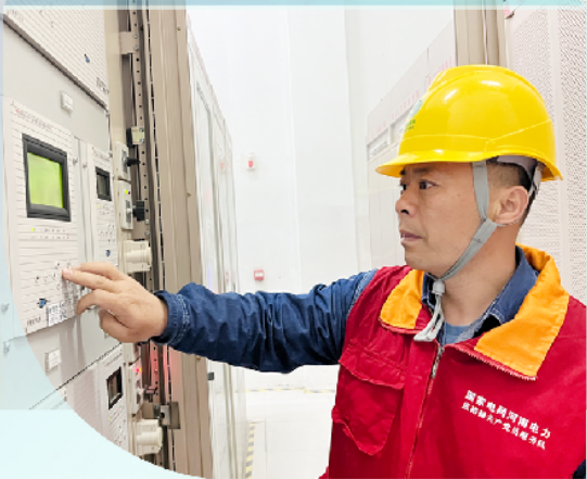
为防止因恶劣天气、外部施工等原因造成用电故障,国网濮阳供电公司安排了300余名用电检查人员对开幕式和闭幕式场馆、赛场、选手驻地酒店进行不间断用电检查。同时,比赛期间,公司还将派出8辆应急电源车、6台移动式箱式变压器,配合不间断电源设备,全力保障大赛开幕式、闭幕式及各项赛事可靠用电。图为4月23日,工作人员正在检修电路。 本报记者 王莹 摄
