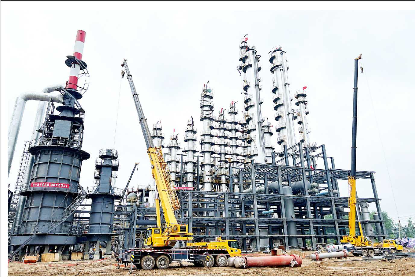
位于范县的濮阳市中汇新材料产业园项目总投资2.1亿元，占地720亩。该项目分两期建设，一期投资2亿元，建设年产5万吨苯酚、丙酮装置。主要产品为纯苯；二期投资2亿元，建设年产5万吨高纯苯加氢装置。预计项目投产后，年产值将达3.2亿元，可实现利税1.4亿元。图为5月5日项目施工现场。
