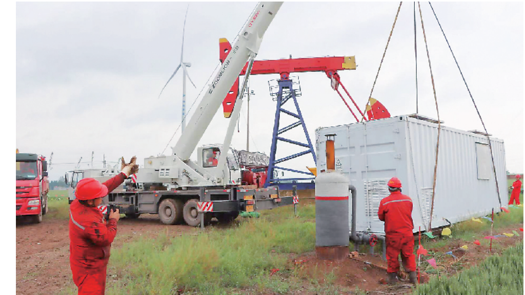
中原油田采油气工程服务中心严抓雨季安全生产，落实现场直接作业环节安全监护、井场道路防滑防、车辆行驶交通安全等措施，全力实施中心“强基固本、提速增效”专项行动，助力采油厂原油上产。图为5月5日，该中心漠东作业区ZY-XJ504队在胡19-66井组织雨中搬迁施工。
