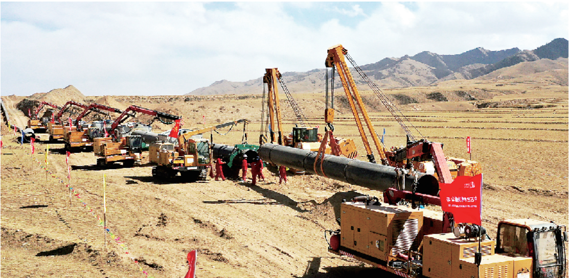
近日，中原油建工程公司在西气东输四线天然气管道工程第七标段所有参建单位中，率先完成主体焊接施工任务，焊接一次合格率98.43%，并喜获甲方贺信，以优异的成绩取得了重要节点胜利，为推动项目整体建设进度发挥了“排头兵”作用。图为施工现场。
