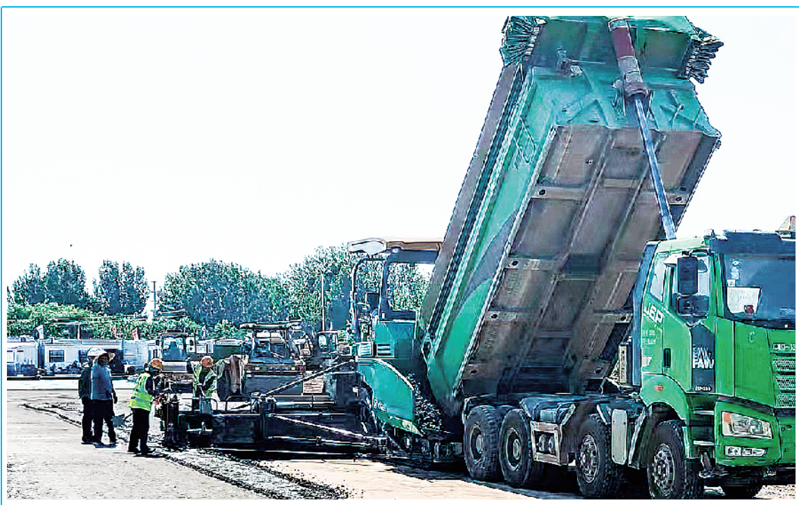
卫都路东延道路项目是我市东北旧城更新改造项目的重要组成部分,是整个项目“四横三纵”路网中的重要“一横”,为东西向主干道。6月30日,该项目开始进行南机动车道水稳摊铺作业,标志着该项目即将进入道路面层施工,为全线通车目标打下了坚实基础。中国一冶濮阳片区负责人介绍,在市廉政教育项目建设中,通过错峰施工、轮流上岗的方式,加快施工进度,争取如期完成各个施工关键节点,确保年底实现通车目标。
