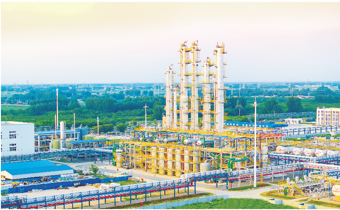
总投资 10.8 亿元的浙江航民年产 8 万吨甲胺装置项目是工业园区的重要节点项目。该项目采用甲醇、液氨作为原料，经气相催化反应生产甲胺，产品不仅纵向延链海尔希三甲基甘氨酸生产项目，还广泛应用于新能源、电子、航天、医药、饲料等行业领域。目前，该项目已进入试生产阶段，达产后预计实现年产值 26 亿元、税收 2.5 亿元，提供就业岗位 300 余个。
