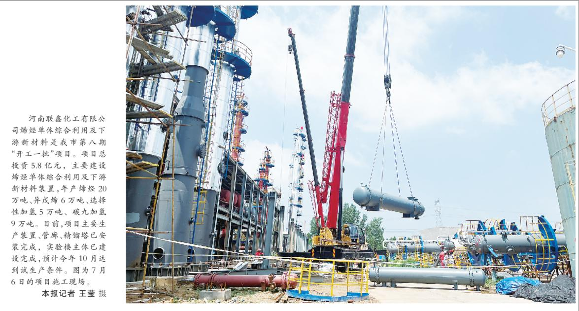
河南联鑫化工有限公司烯烃单体综合利用及下游新材料是我市第八期“开工一批”项目。项目总投资5.8亿元,主要建设烯烃单体综合利用及下游新材料装置,年产烯烃20万吨、异戊烯6万吨、选择性加氢5万吨、碳九加氢9万吨。目前,项目主要生产装置、管廊、精馏塔已安装完成,实验楼主体已建设完成,预计今年10月达到试生产条件。图为7月6日的项目施工现场。
