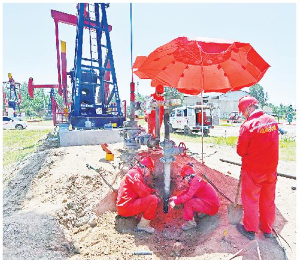
为应对连日高温,中原油田地面工程抢修中心把改善一线工人野外施工环境作为“我为群众办实事”实践活动的具体实践,为一线施工班组配备了遮阳棚、遮阳伞、保温桶、桌椅“爱心四件套”,为酷暑中工作的员工提供了一片阴凉的工作和休息之地。图为7月18日,该中心濮城服务工区职工正在濮4-18井遮阳伞下焊接井口装置。
