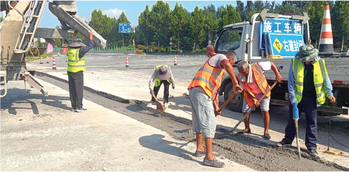
新诚公司在濮阳南高速口积水路段施工。
