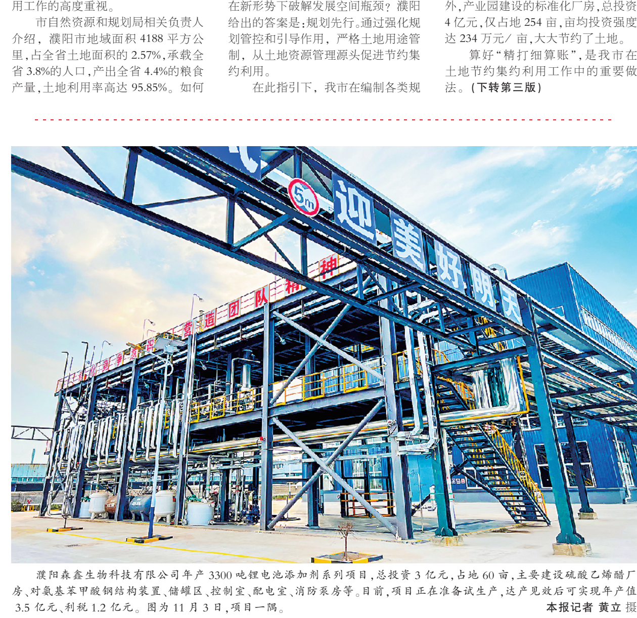
濮阳森鑫生物科技有限公司年产 3300 吨锂电池添加剂系列项目,总投资 3 亿元,占地 60 亩,主要建设硫酸乙烯酯厂房、对氨基苯甲酸钠结构装置、储罐区、控制室、配电室、消防泵房等。目前,项目正在准备试生产,达产见效后可实现年产值 3.5 亿元、利税 1.2 亿元。图为 11 月 3 日,项目一隅。
