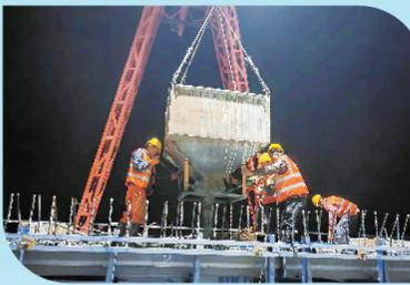
50米波箱钢腹板箱梁混凝土浇筑。
