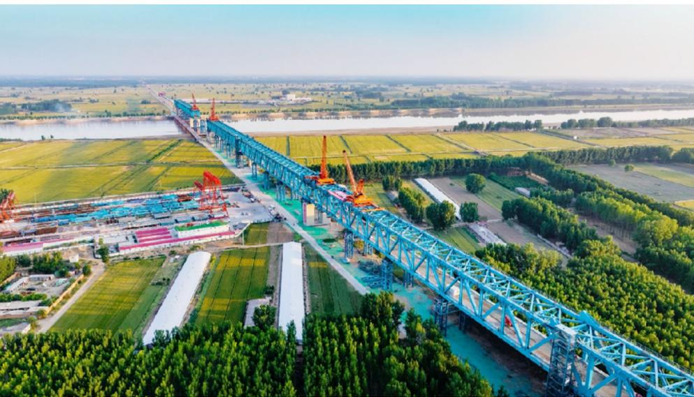
5月18日,随着最后一根重约10.7吨的上平联精准吊装到位,标志着由雄安高速铁路有限公司建设、中铁四局集团有限公司承建的雄商高速铁路黄河特大桥主桥河南侧顺利合龙,全桥钢桁架架设进度超87%,为后续全桥贯通及拱肋安装提升打下坚实基础。雄商高铁北起河北雄安新区,南至河南商丘站,线路全长约552公里,是我国高速铁路网“八纵八横”之京港(台)通道的重要组成部分。
