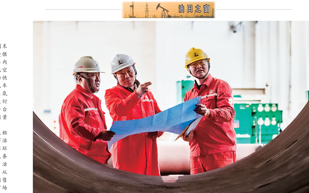
中石化中原油建工程有限公司持续提升地面工程技术和管理水平,提高工程质量,缩短建设工期,依托“五化”建设在石油化工设备厂的全面应用,推动工程建设模式从传统的现场施工向工厂化预制、机械化作业、模块化施工转变,橇装制造驶入高质量发展的“快车道”。图为11月24日,该公司技术人员在橇装制造现场,检查原油脱水分离器筒节环焊缝是否与蓝图开孔冲突。①
