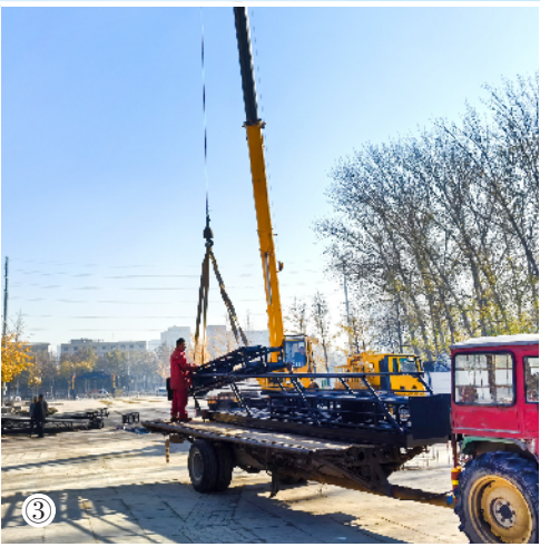
图②③④河南省第十二届杂技展演暨首届“金龙杯”杂技艺术周即将开幕，杂技主题公园内移动剧场正在加紧建设中。
