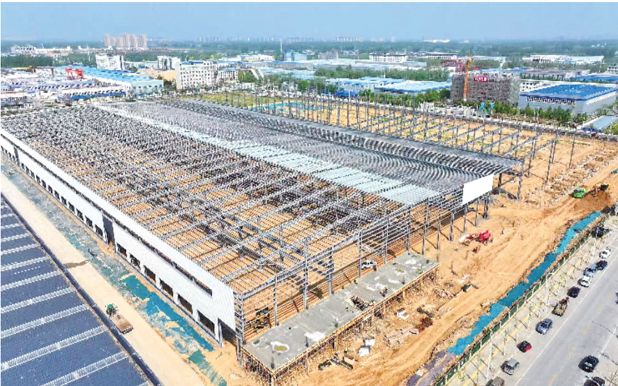
位于濮东产业集聚区的中原总机石油设备有限公司新能源车辆整车制造项目建设工地。
