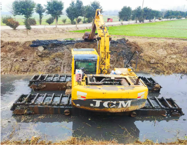
为全面推进今冬明春农业农村重点工作,入冬以来,范县高码头镇充分发挥村“两委”干部和党员群众力量,采取“人工清理+挖机操作”相结合,多点位全面施工,全面清理辖区河道淤泥,平整河床,确保沟渠畅通顺畅。图为 12 月 23 日,工作人员驾驶挖掘機正在沿着古张路沟七里河段进行疏通。⑩
