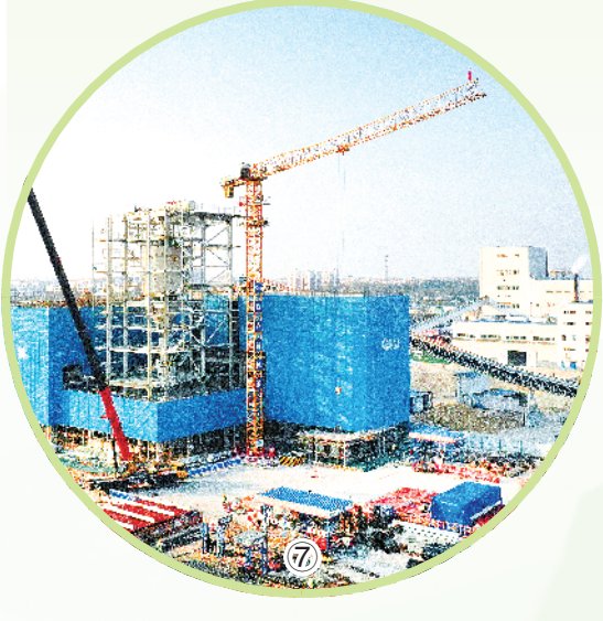
图① 河南能源中原大化异丁烯酸甲酯项目开工现场。 图② 蓝星化工鸟瞰图。 图③ 濮阳人才日(周)经开区专场招聘会在万达广场举行。 图④ 胡村乡万达农林红薯种植基地。 图⑤ 王助镇香瓜小镇。 图⑥ 豫粮集团濮阳粮食产业园。 图⑦ 龙丰纸业二期建设现场。
