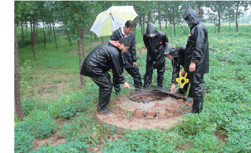
日前，濮阳县审计局在城市排水处理设施及配套管网工程建设情况专项审计调查中，重点关注竣工测绘报告工程量与现场测量工程量是否一致、排水设施和管网铺设是否按照图施施工、管网砂回填是否存在偷工减料等情况。图 为审计人员在核实污水井工程量。 庞晨静 摄
