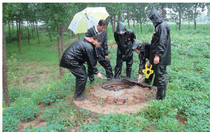
日前,濮阳县审计局在城市排水处理设施及配套管网工程建设情况专项审计调查中,重点关注竣工测绘报告工程量与现场测量工程量是否一致、排水设施和管网铺设是否按照图施工程、管网回填是否存在偷工减料等情况。图为审计人员在核实污水井工程量。 鹿晨静 摄
