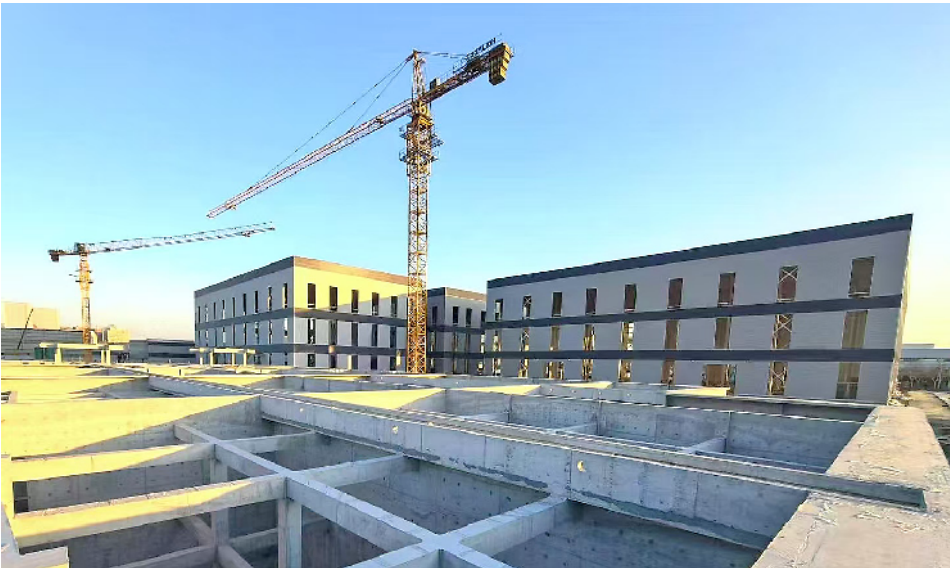
2 月 4 日, 河南省荣豫羽绒有限责任公司建筑工地。
