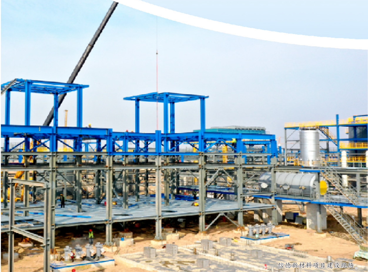
信德新材料项目建设现场。
