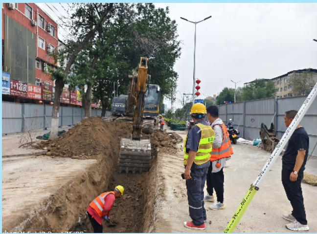
公司员工进行管线巡护。
