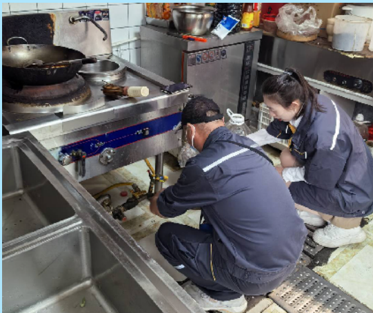
公司员工对商业用户进行安全用气检查。
