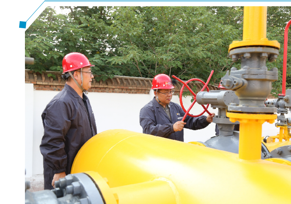
5月29日,总经理张文峰到东濮路调压站进行安全检查。
