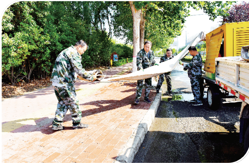
为切实提升城市防汛应急处置能力,保障汛期市民生命财产安全,6 月 17 日,经开区市政环卫局组织开展了 2025 城市防汛应急演练。⑮
