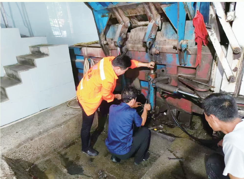
为有效解决垃圾转运设备箱体滴、洒、漏问题,市环卫中心组织人员加班加点开展生活垃圾转运设备故障集中检修攻坚战,集中修复存在严重渗漏风险的压缩箱体32个,更换老化密封条100余米,为35个压缩箱体增补了缺失的排污堵头,完成了30余根液压油管及配套密封件更换等。图为7月21日,市环卫中心工作人员在更换液压油管及配套密封件。⑮
