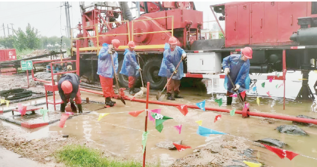
7 月 23 日,面对突如其来的暴雨袭击,中原油田采油气工程服务中心文卫作业区组织员工赶赴所属井场紧急排涝并检查户外设备,通过开挖排水渠、清排积水等措施,全力保障油田生产安全与进度。⑮
